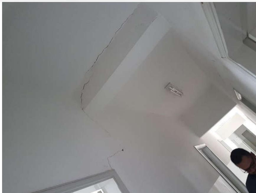
**Figura 1 - Viga fissurada**
